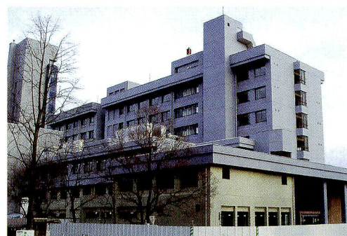
改修中の総合理工学部1号館 (平成21年4月には再び美しい学舎をみることができます)
