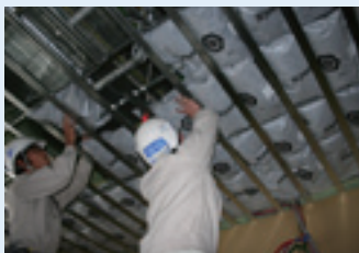
新病棟病室天井への敷設作業
